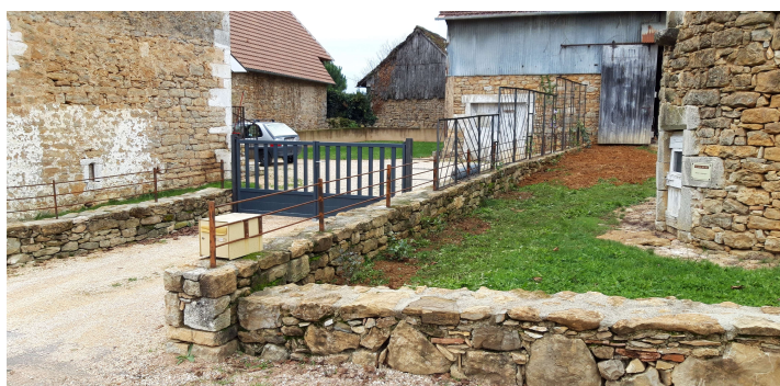
Clôture en métal entre le local technique et la Maison Aurélie
