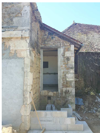
Ouverture réalisée à l'arrière de la maison
