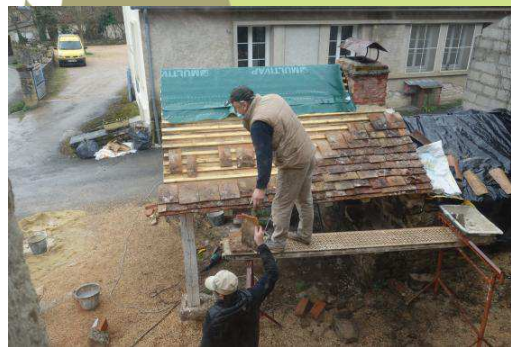
Restauration du four à pain
