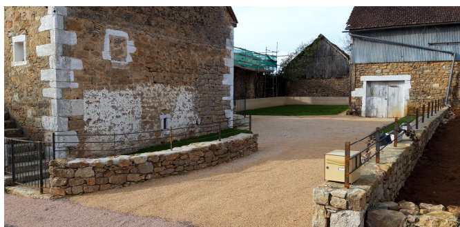
La maison Aurélie, travaux achevés
